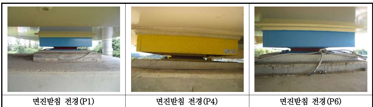
【사진 16.3.12】 교량받침 전경
