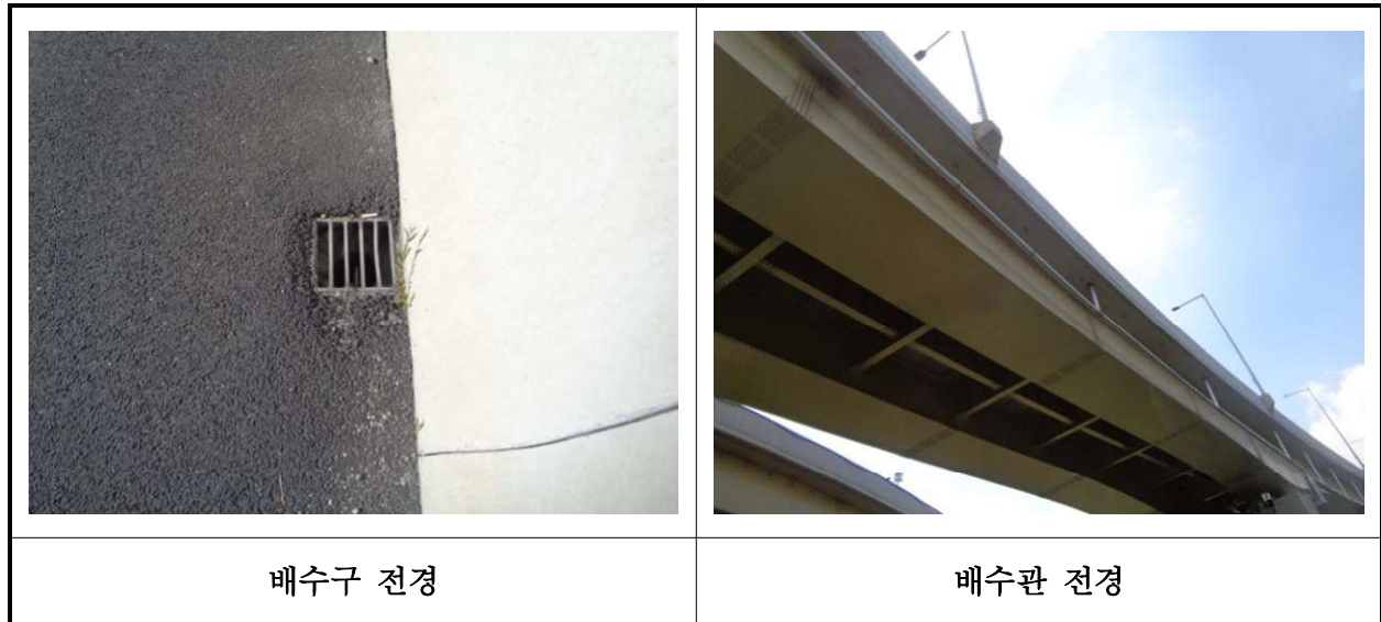
【사진 16.3.21】 배수시설 전경
