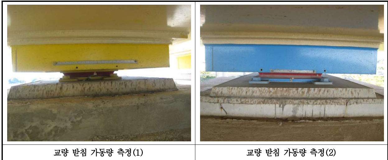
【사진 16.3.15】 교량받침 이동량 측정
