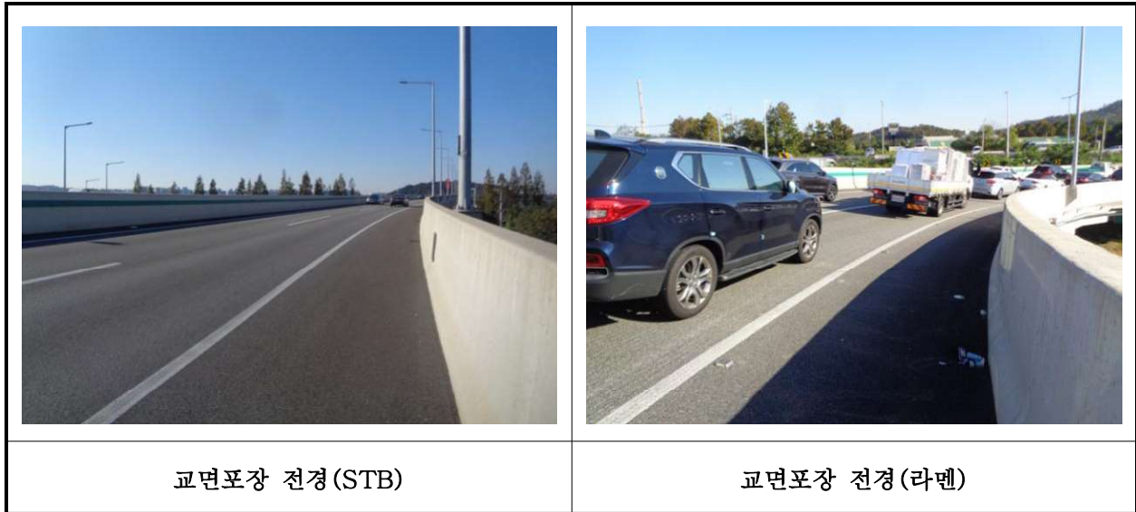
【사진 16.3.19】 교면포장 전경
