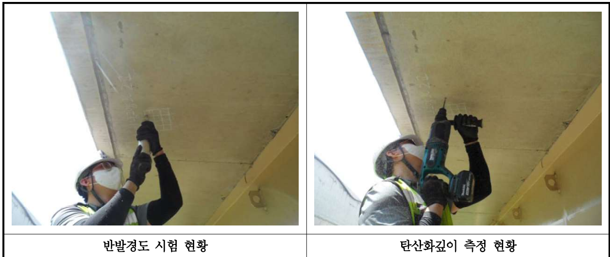
【사진 16.4.1】 콘크리트 내구성조사 현황
