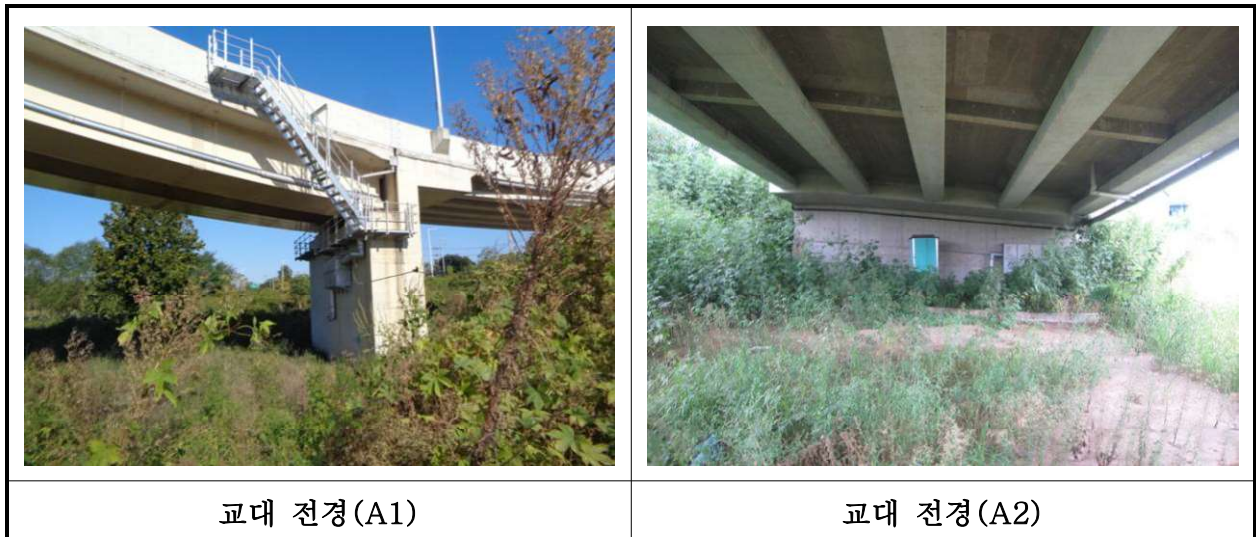
【사진 16.3.8】 교대 전경
