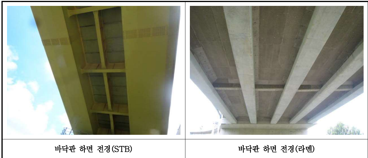
【사진 16.3.2】 바닥판하면 전경
