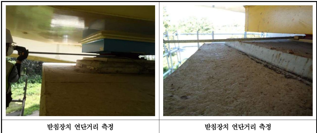
【사진 16.3.14】 교량받침장치 연단거리측정
