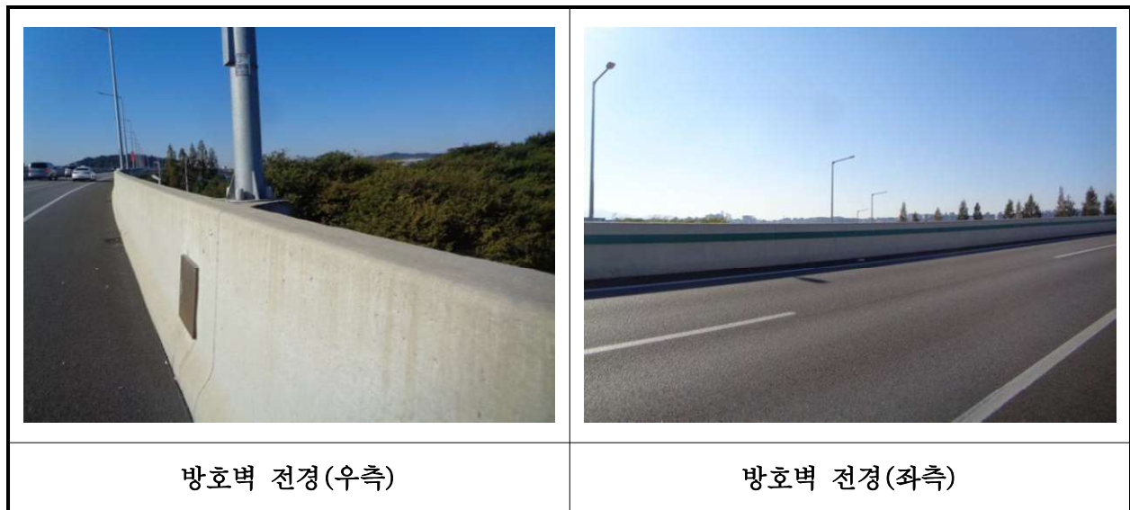
【사진 16.3.23】 방호벽 전경
