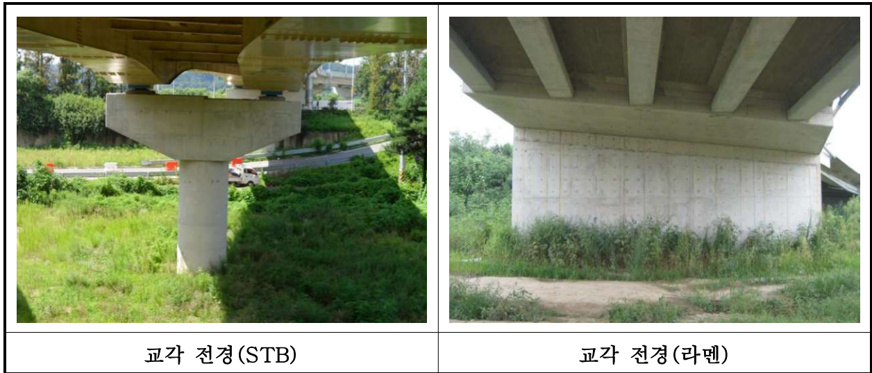
【사진 16.3.10】 교각 전경
